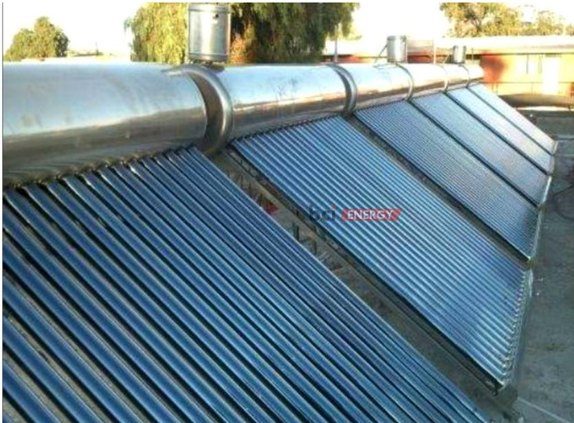
El tanque auxiliar tiene importancia por encargarse del llenado automático del tanque principal. Con esto se evita el problema del calentamiento de tanque seco, como se explica en la página siguiente.
