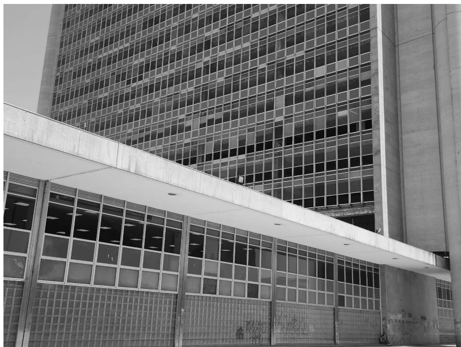
Figura 2: Início do desmonte da fachada leste. Setembro/2024. Acervo Iphan-DF.
