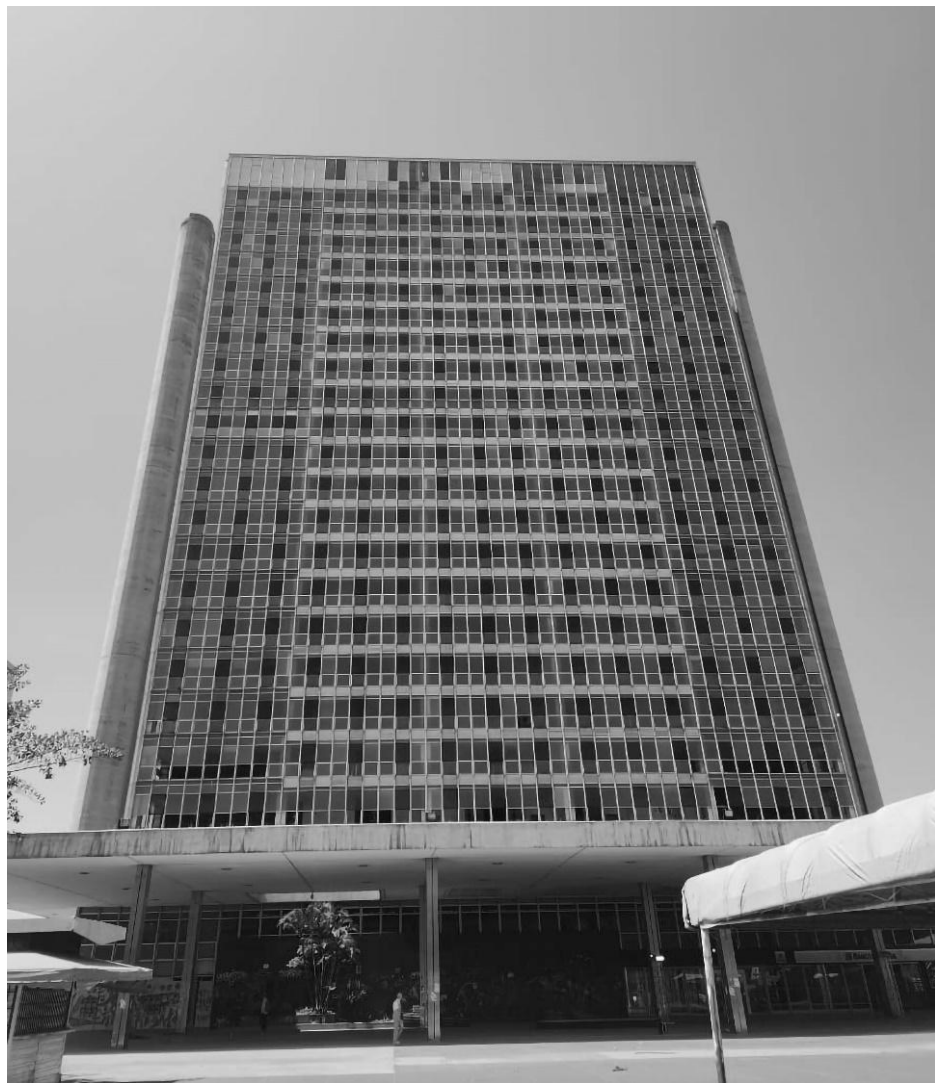
Figura 5: Edifício Sede I, fachada oeste. Acervo Iphan-DF.
