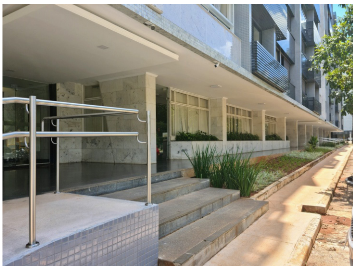
Figura 5: Salão de festas no pavimento térreo bloqueando passeio e visual de pedestres, bloco C da SQS 107. Fonte: Flaviana Lira, 2013.
