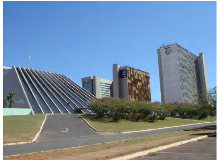
Imagem. Entrada Sul com grupo de Calliandra twedii (não conforme ao projeto)
