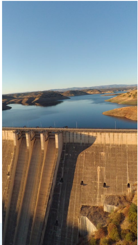
› Presa de la Fernandina
