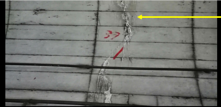
actual inwall crack on site
