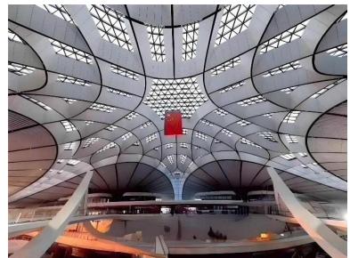
吊頂安裝定位放線
