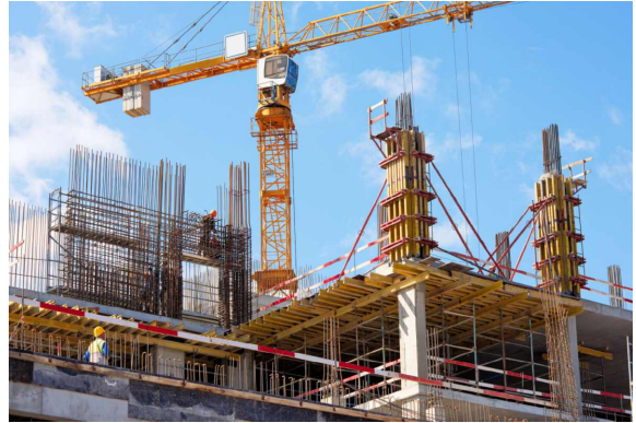
主體結構放線(非小戶型住宅)
