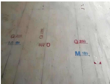
建造二次結構放線
