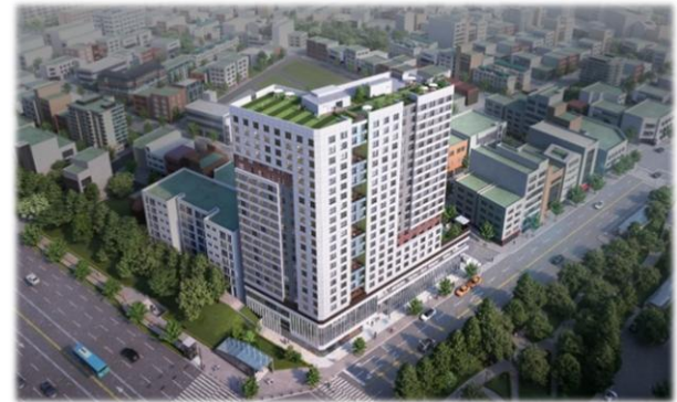
문정역 역세권청년주택 신축공사
