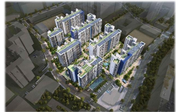
등촌 부영아파트 리모델링
