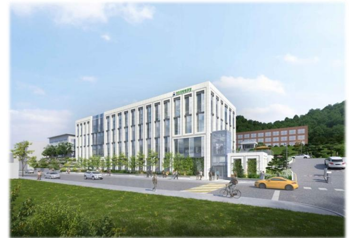
● 경인 지방병무청 제2병역판정검사동 증축공사
