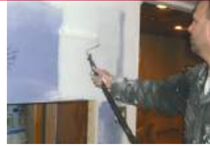
Applying primer to new drywall.
