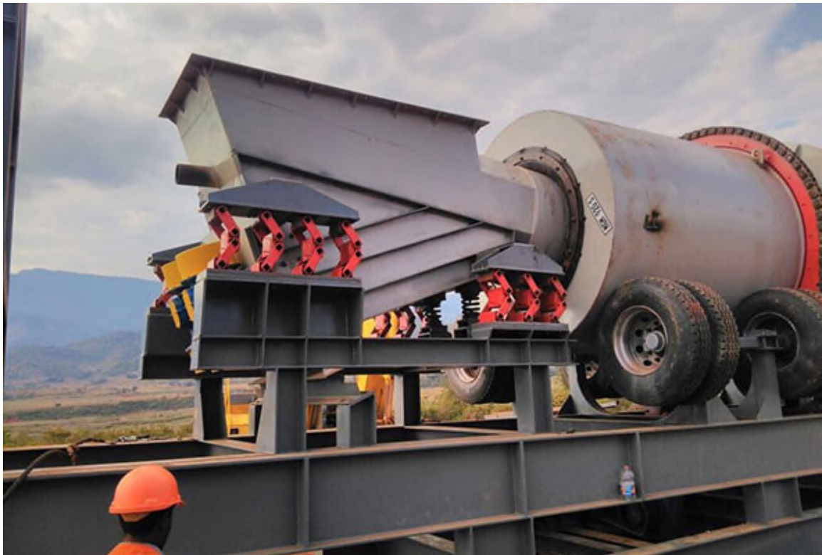
INSTALACIÓN DE UNA DE LAS LAVADORAS DE TIERRA AU INSTALLATION OF ONE OF THE EARTH WASHING MACHINES
