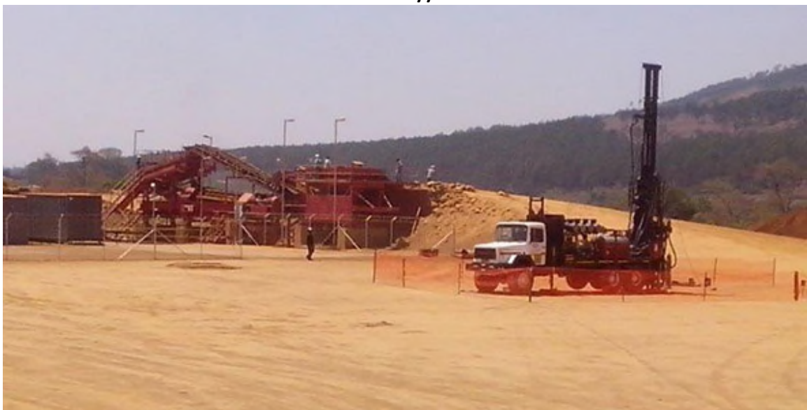
UNIDAD DE PERFORACIÓN, POZOS DE AGUA PARA LAVADO // DRILLING UNIT, WATER WELLS FOR WASHING
