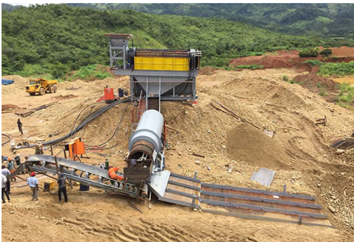
VISTA GENERAL DE UNA DE LAS PLANTAS PRINCIPALES DE PROCESADO OVERVIEW OF ONE OF THE MAIN PROCESSING PLANTS
