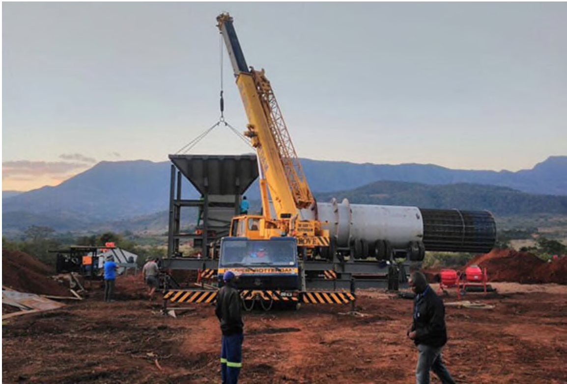
MONTAJE DE UNA DE LAS TOLVAS DE LAVADO ASSEMBLY OF ONE OF THE WASHING HOLES
