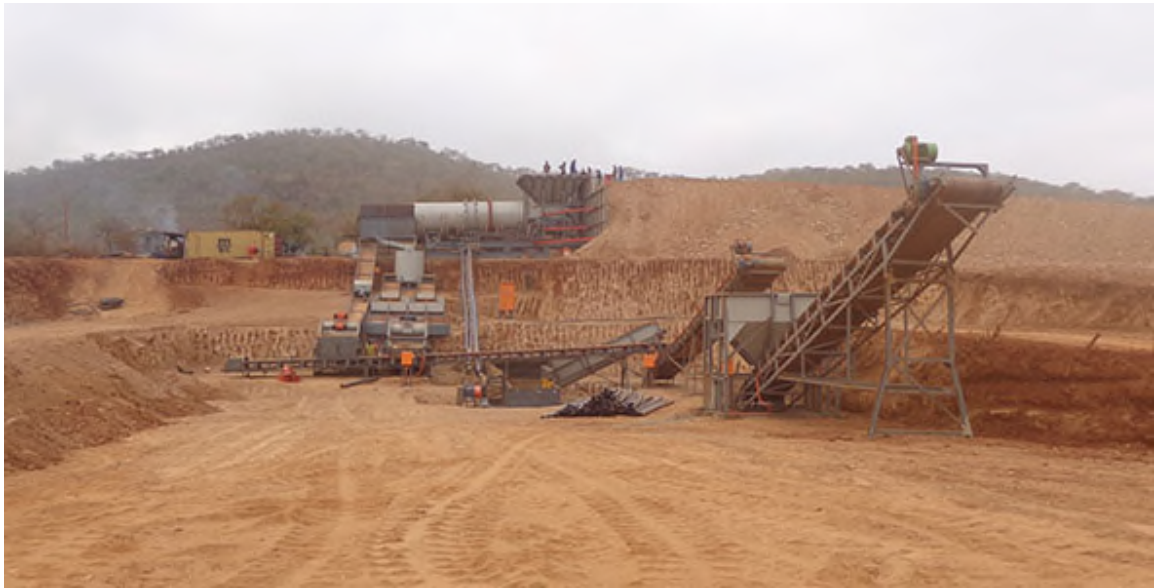
ZONA PRINCIPAL DE TRATAMIENTO DE TIERRAS // MAIN AREA OF LAND TREATMENT
