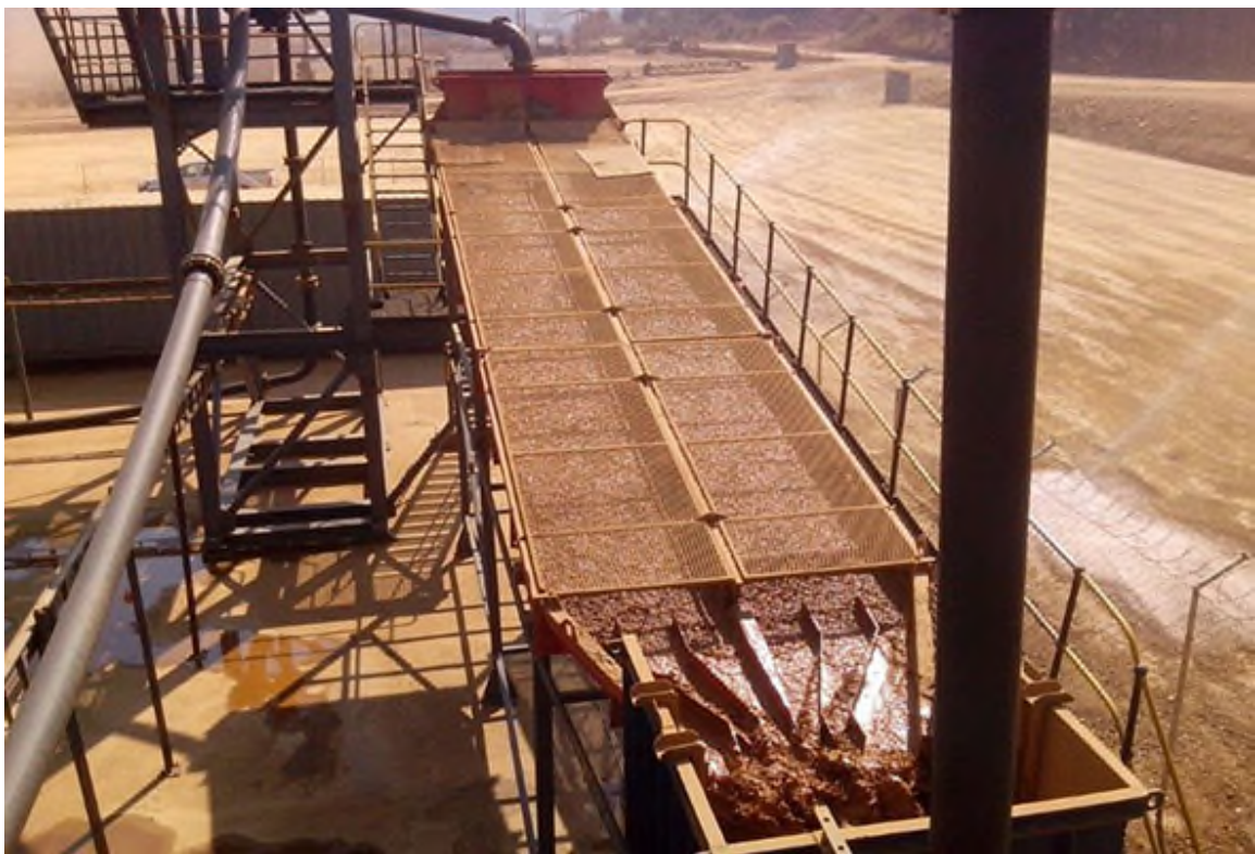
CANALES DE PRECIPITADO Y ATRAPADO DEL METAL PRECIPITATED AND TRAPPED METAL CHANNELS
