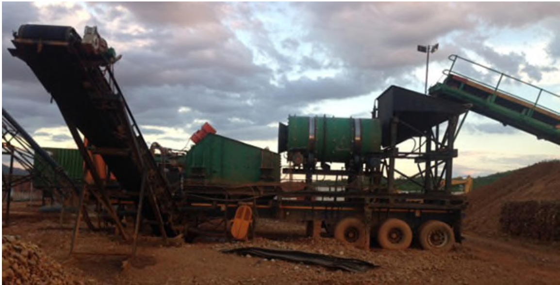
PLANTA MÓVIL DE PROCESADO // MOBILE PROCESSING PLANT
