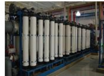
UF Membrane Filtration —2013
