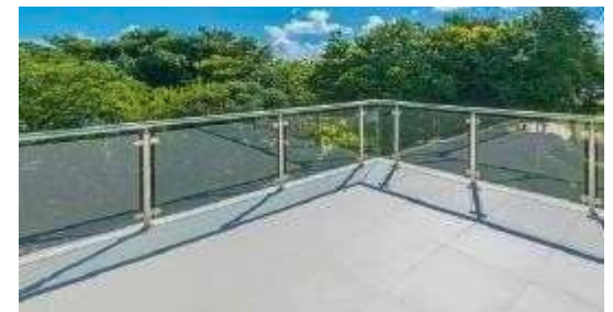
GLASS BALUSTRADE / EDGE PROTECTION
