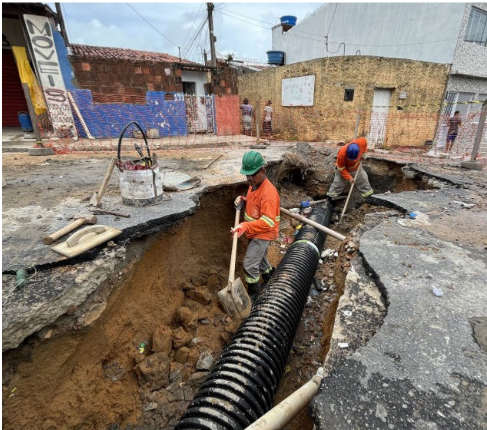
PREFEITURA recupera galerias e tubulações danificadas pelo tempo e por ligações irregulares de esgoto
