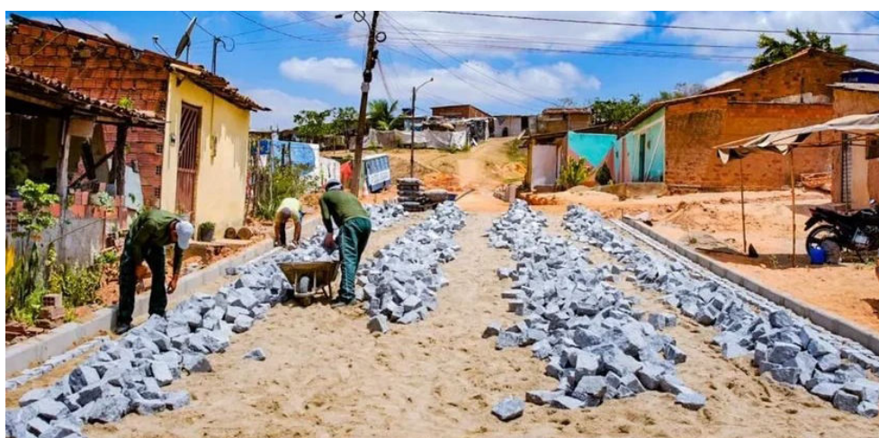
PAVIMENTAÇÃO E SANEAMENTO é sonho antigo dos moradores de Mangabeiras
