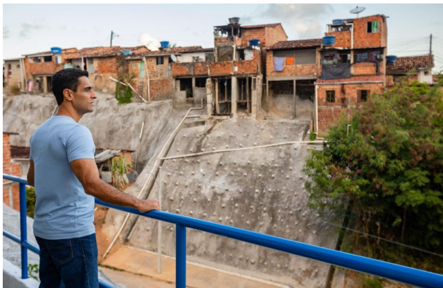
PROGRAMA DE CONTENÇÃO de encostas fez mais de 40 intervenções
