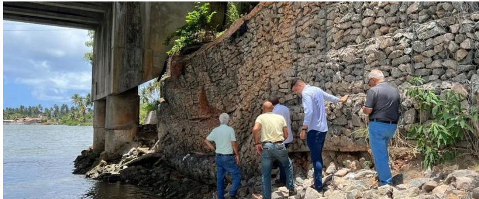
EQUIPE DO DER durante inspeção na Ponte da Massagueira
