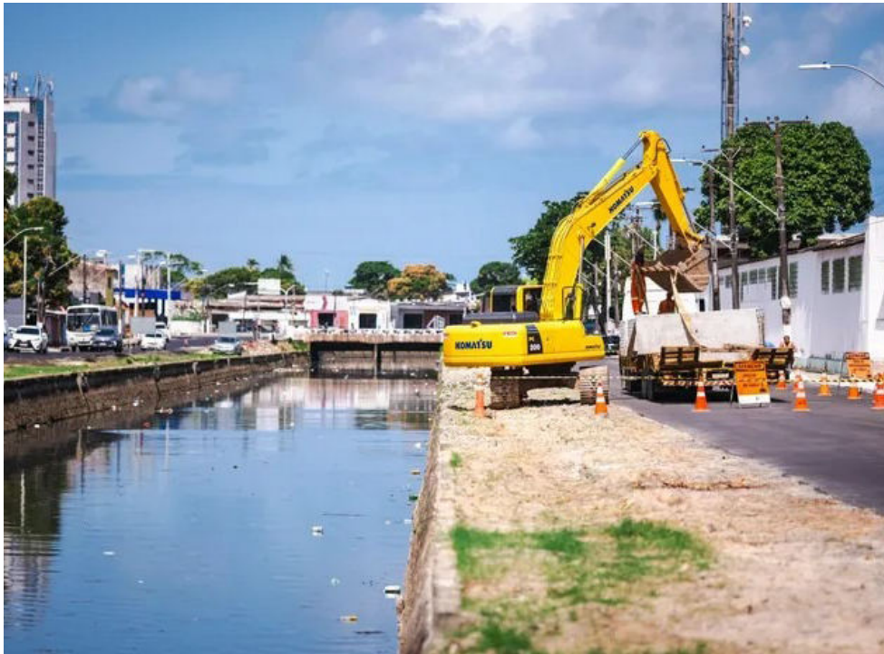
SERVIÇOS de hidro mecânica e eletromecânica das estações elevatórias estão na reta final
