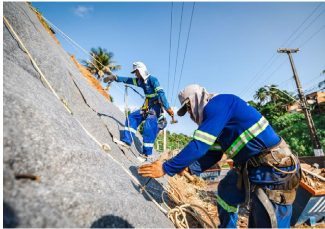
OBRAS NAS ENCOSTAS de Maceió estão à todo vapor
