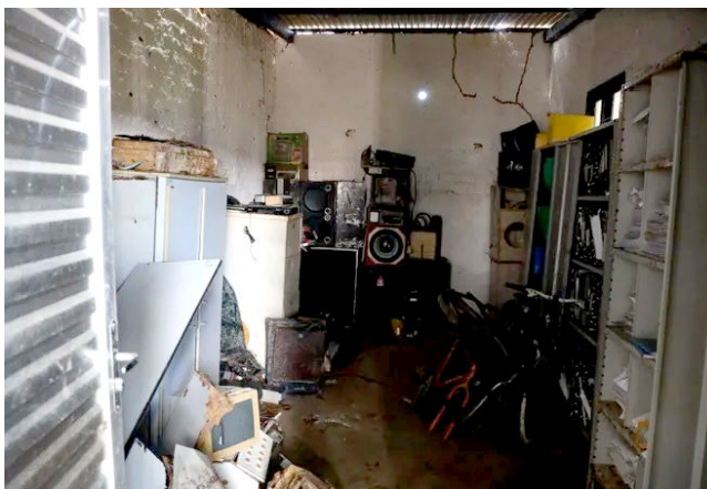
MOFO, CUPINS E INFILTRAÇÕES estão entre os problemas encontrados
