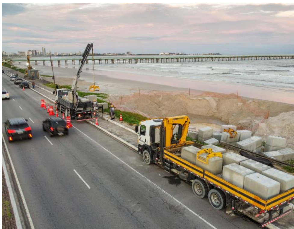
PRAIA DO SOBRAL terá 140 metros de contenção com blocos maciços na fundação e anéis hexagonais
