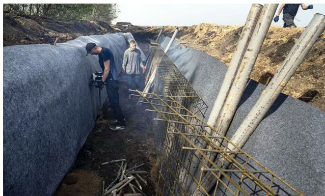
HOMENS trabalham em construção de nova linha de defesa da Ucrânia
