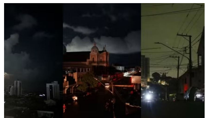
INCÊNDIO começou por volta das 0h30, na subestação de Bateias
