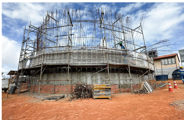
SEINFRA trabalha para garantir acesso à água potável de qualidade
