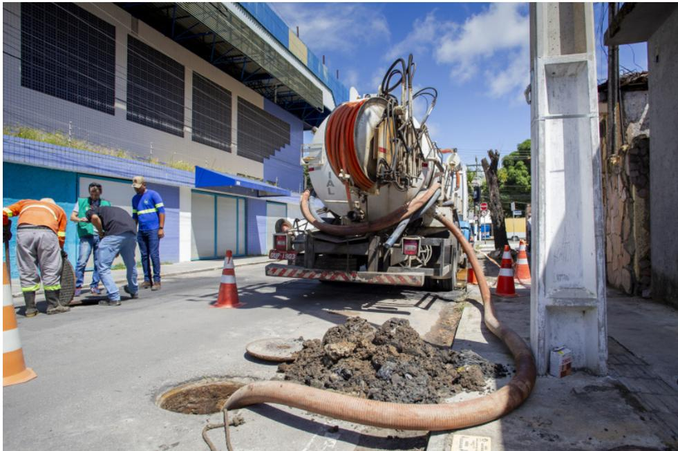
**NA PONTA VERDE,** técnicos da Semurb e da Seminfra fecharam a entrada da rede de esgoto na drenagem
