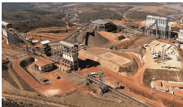
ATIVIDADE DA MINERADORA pode ser causa de danos aos imóveis
