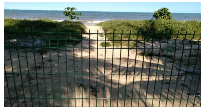
INSTALAÇÃO DE GRADES impede o acesso ao trecho da praia
