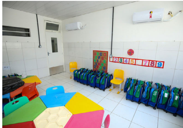
EQUIPAMENTOS de ar condicionado começam a ser instalados
