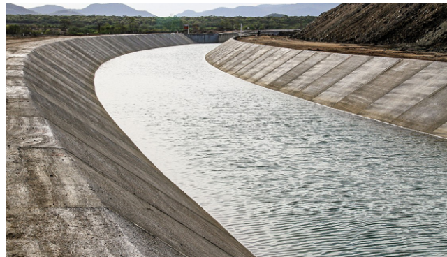
CANAL DO SERTÃO é maior obra hídrica do Estado e está no trecho V
