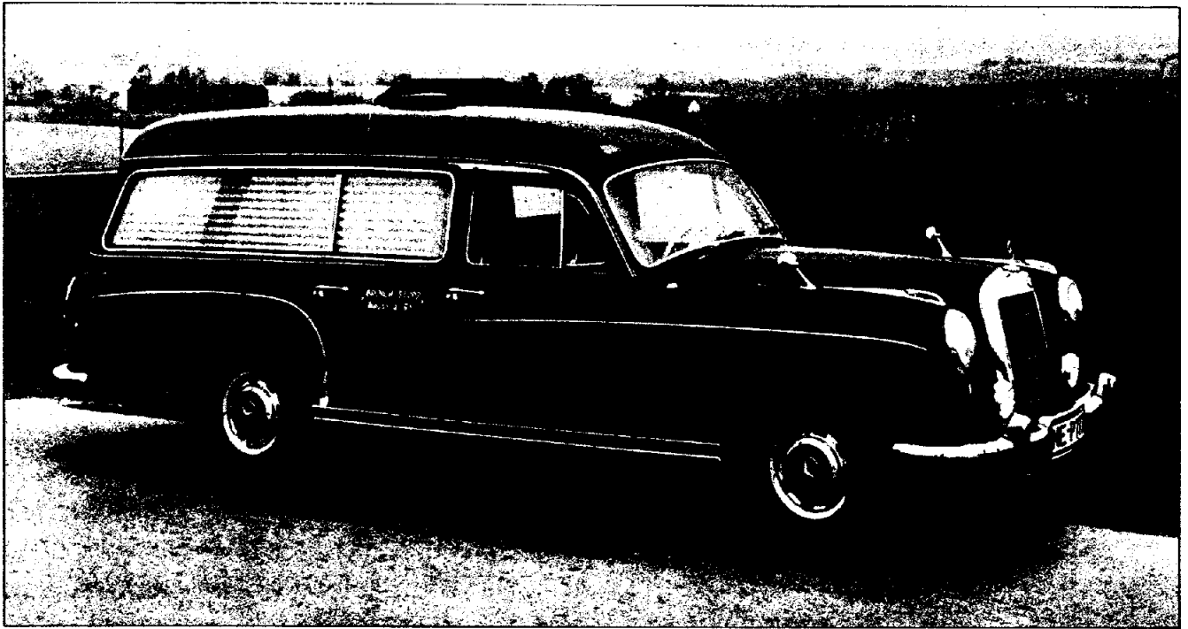
Daimler-Benz 220 S aus dem Jahr 1959 mit Rappold-Karosserie aus Wülfrath. Zu den serienmäßig vorhandenen Blinkleuchten auf den Kotflügeln wurden noch die Blinker des „kleinen Mercedes“ 190 montiert. Frei nach dem Motto: „doppelt geblinkt, läßt es sich besser abbiegen.“ (17)
