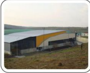
İSTAÇ KEMERBURGAZ KOMPOSTLAŞTIRMA TESİSİ
