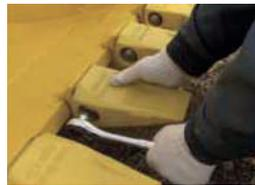
Coloque el buje, la arandela y el perno, luego apriete con una llave de trinquete.
