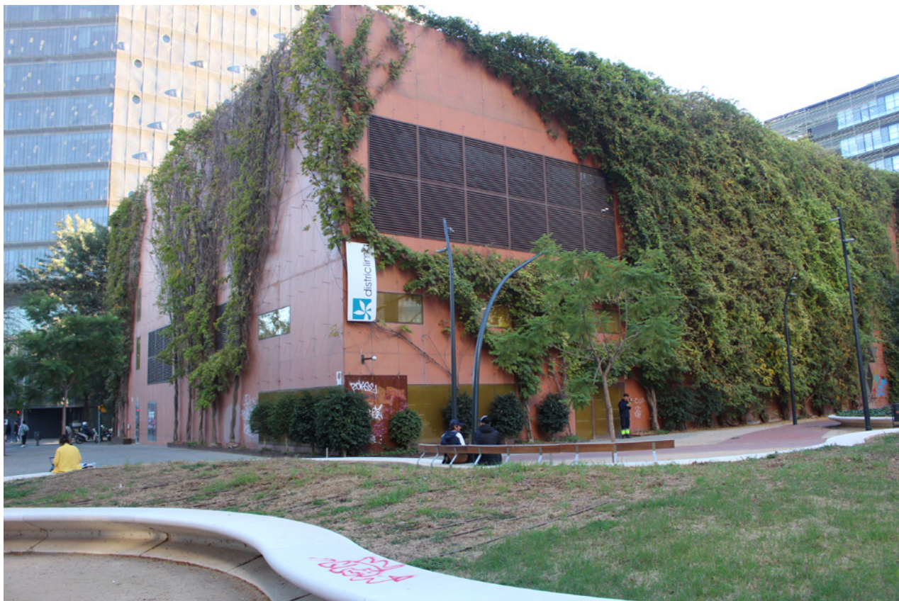
A Districlima foi criada em 2002 para implementar, pela primeira vez na Espanha, uma rede de aquecimento e arrefecimento urbano para utilização em aquecimento, climatização e água quente sanitária
