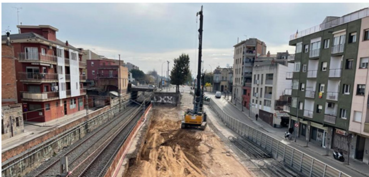
Construção do túnel subterrâneo para abrigar os trilhos do trem, em 2022
