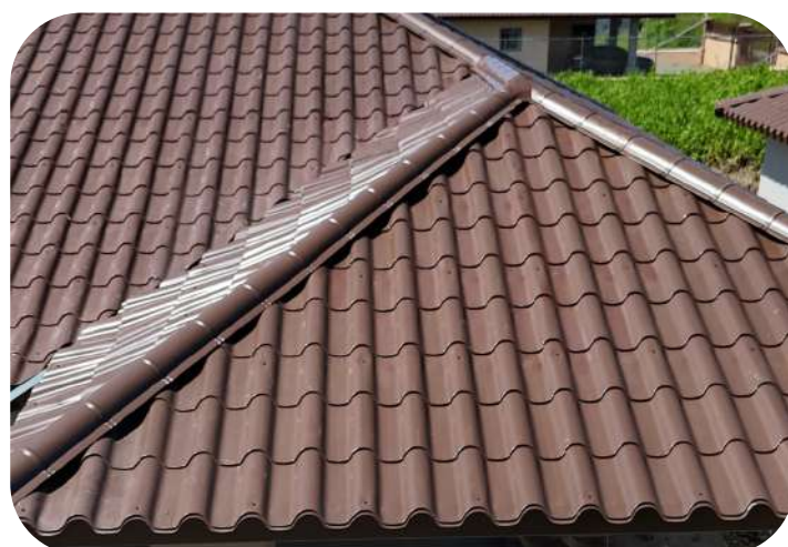
✓ TECHO DE TEJAZINC
