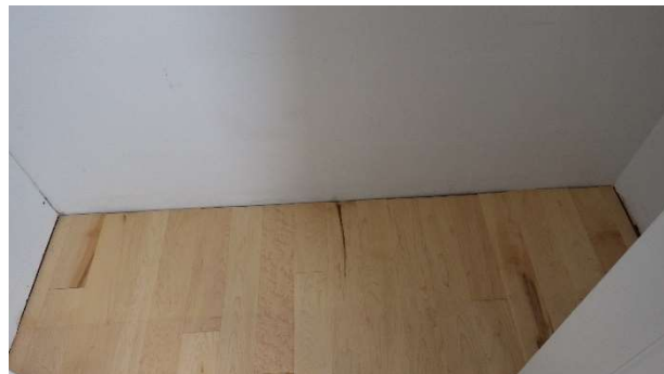
Boiseries de finition à installer et peindre
