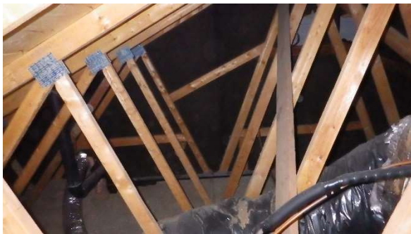
Structure de toit
