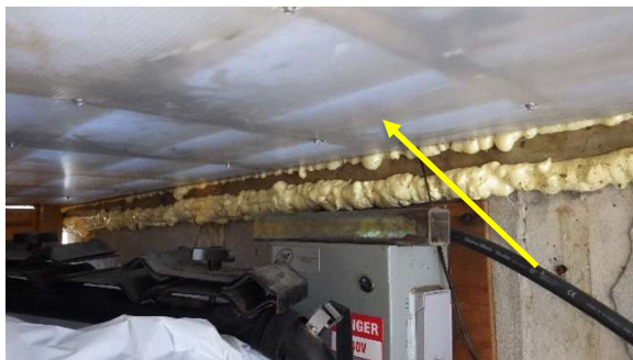
Feuille de Coroplast à enlever sous le balcon arrière
