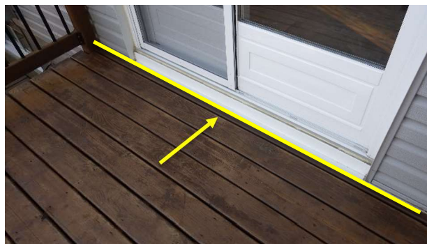
Jonction des matériaux balcon arrière
