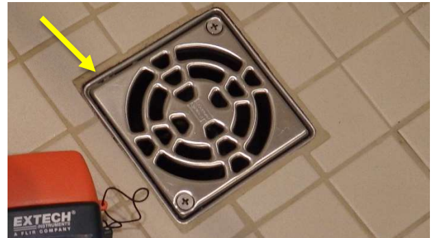
Ajouter un scellant autour du drain
