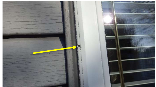
Fenêtre façade latérale gauche
