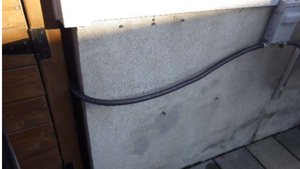
Câble électrique à fixer adéquatement
