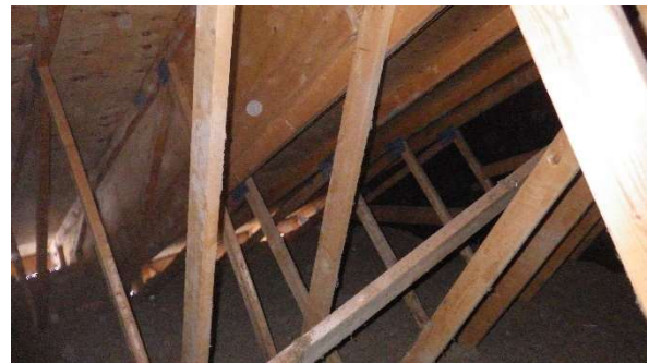
Structure de toit
