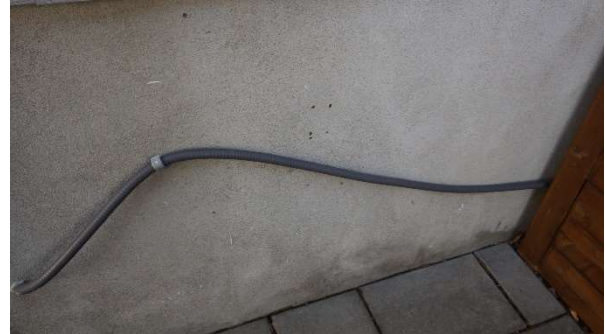
Câble électrique à fixer adéquatement
