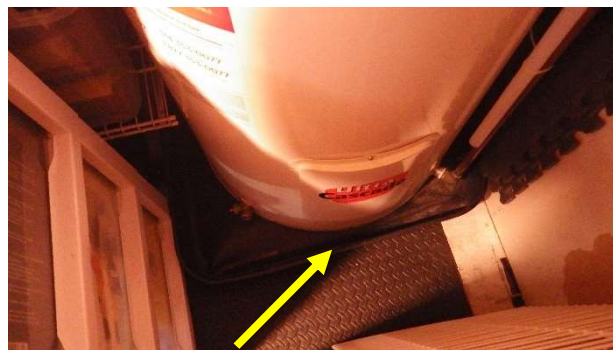
Conduit à installer entre le bassin et le drain de plancher
