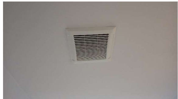
Ventilateur d'évacuation de la salle de bain au sous-sol
