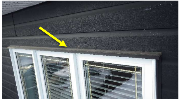
Interstice au-dessus du solin scellé
