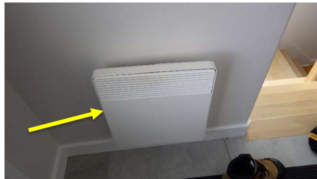
Thermostat et convecteur non fonctionnels à l'entrée avant
