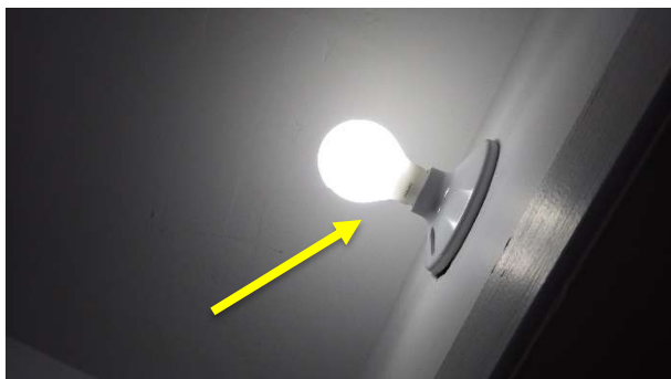
Garde-robe de l'entrée avant
