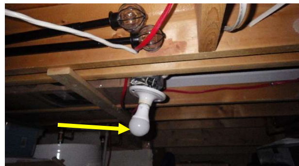
Sous l'escalier au sous-sol
