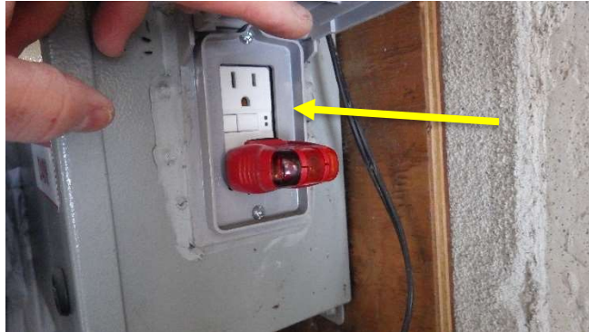
Prise de courant non fonctionnelle
