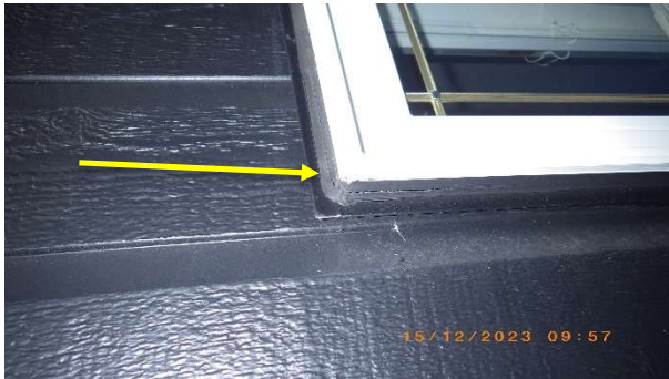
Fenêtre façade avant
