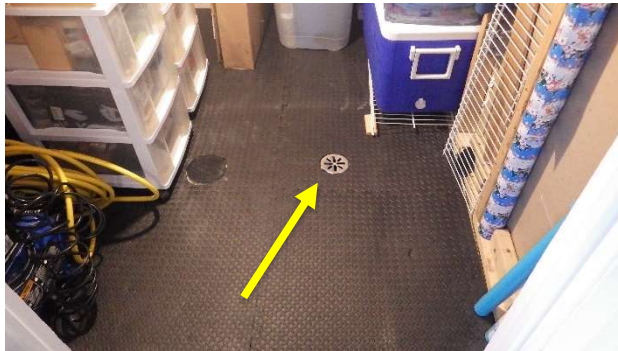
Drain de plancher sous l'escalier
