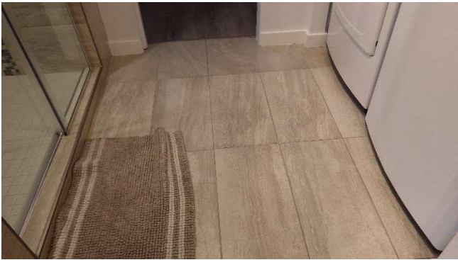
Revêtement salle de bain sous-sol
