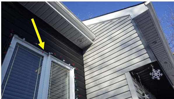
Interstice au-dessus du solin scellé
