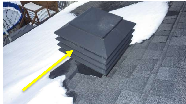
Ventilateur de toit (Maximum)
