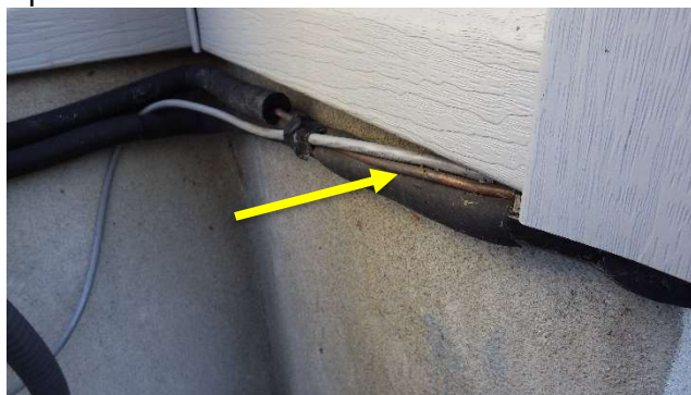
Isolant manquant
