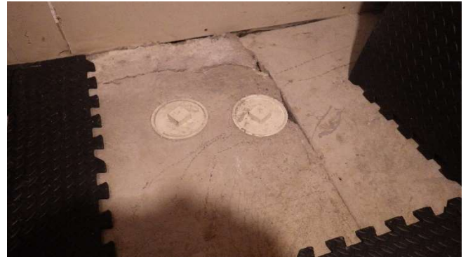
Partie visible de la dalle de béton sous l'escalier
