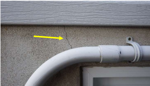
Vue rapprochée fissure coin haut fenêtre arrière
