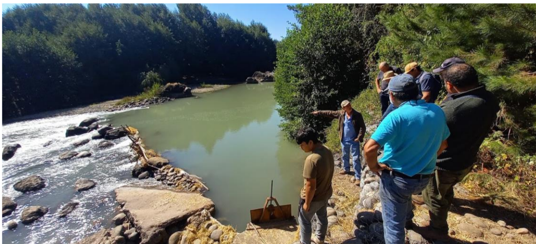
Visita a bocatoma del canal Duqueco Alto, junto a la directiva de la comunidad.
