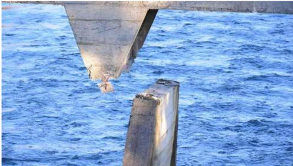
*Figura 48. Daño estructural Puente Las Canoas, Asociación de Canalistas Biobío Negrete.*
