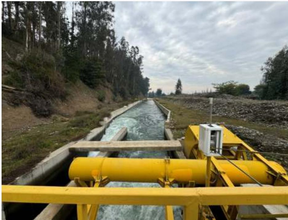
Figura 7. Compuerta de control hidráulico de la Asociación de Canalistas Biobío Negrete.
