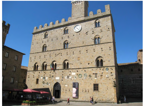
IMG_8949 Palazzo Dei Priori - Volterra
