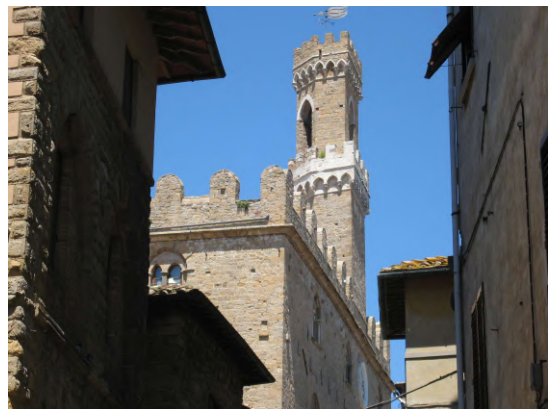
IMG_9043 Palazzo Dei Priori - Volterra
