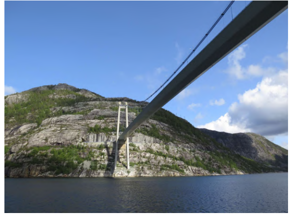
4403 Lysefjord Bridge Lysefjordbrua 1995
