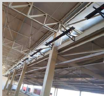
INSTALAÇÃO DE BARRAMENTO
