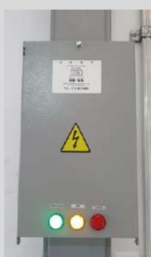
CAIXA DE DERIVAÇÃO (PLUG-IN) COM SINALEIRO
