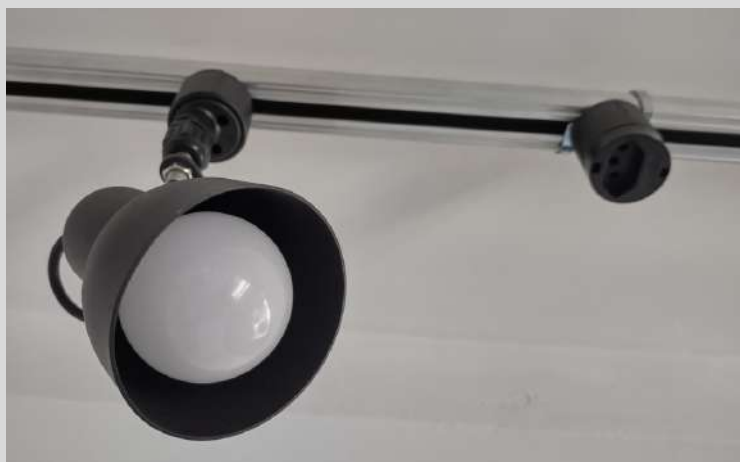
TRILHO ELETRIFICADO (MINI-WAY) COM TOMADAS PLUG-IN E LUMINÁRIA
