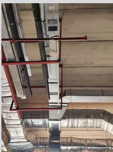
INSTALAÇÃO DE BARRAMENTO
