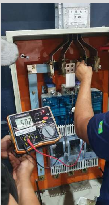
TESTE COM MEGÔMETRO
