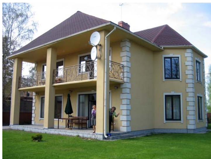
Jānim Dambītim ir skaists dzīvoklis ģimenes mājā Pārdaugavā, Mārupē, nesen celtās ēkas pirmā stāvā
