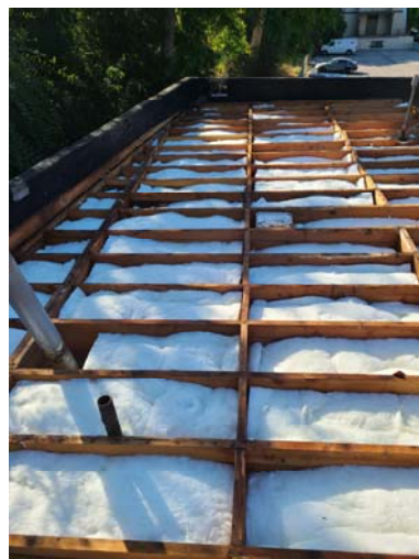
Dubultrāmis uz jumta slīpuma noteces veidošanai
