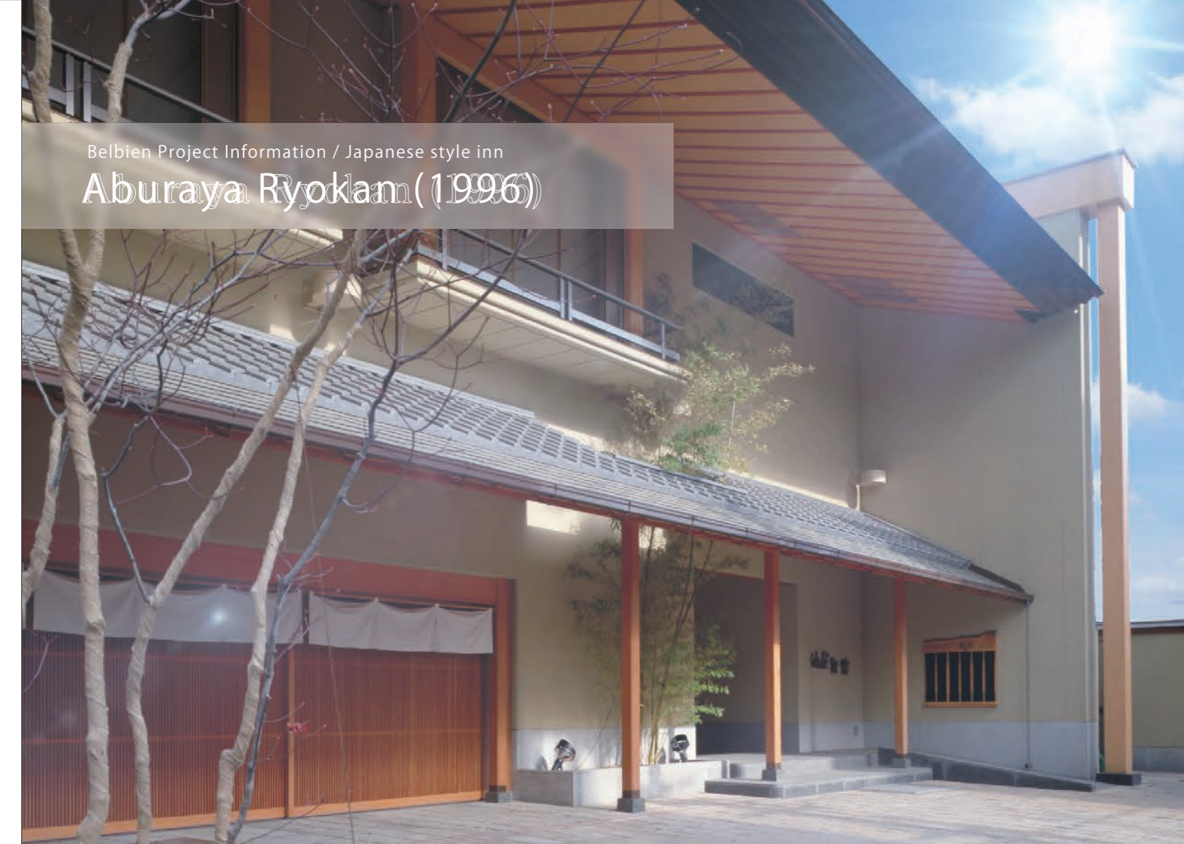
Photo : Nacasa & Partners Inc.
