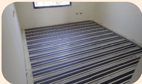
Step.2 鋪設斷熱 / 隔音層
