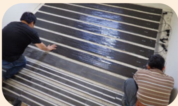
Step.3 鋪設電熱片
