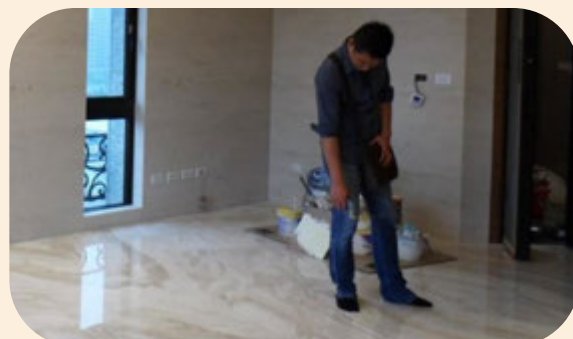
Step.7 地板鋪設完成後檢測及驗收
