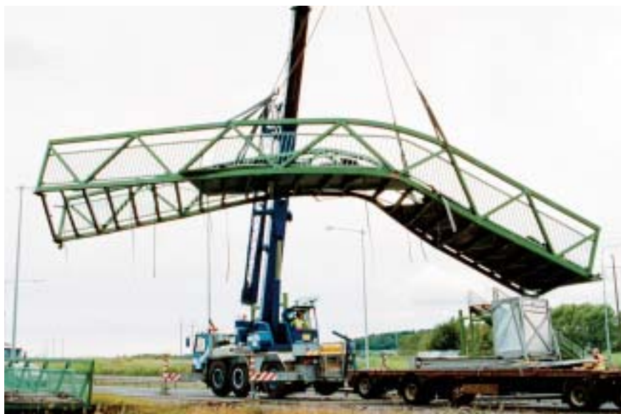
För att lyfta säkert måste vissa grundläggande säkerhetsregler uppfyllas, bland annat måste lyftredskap vara besiktade och godkända för det aktuella lyftet.
