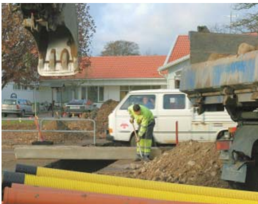
Vägarbete ska vara organiserat på ett sådant sätt att det ger hög säkerhet för de som utför arbetet.
