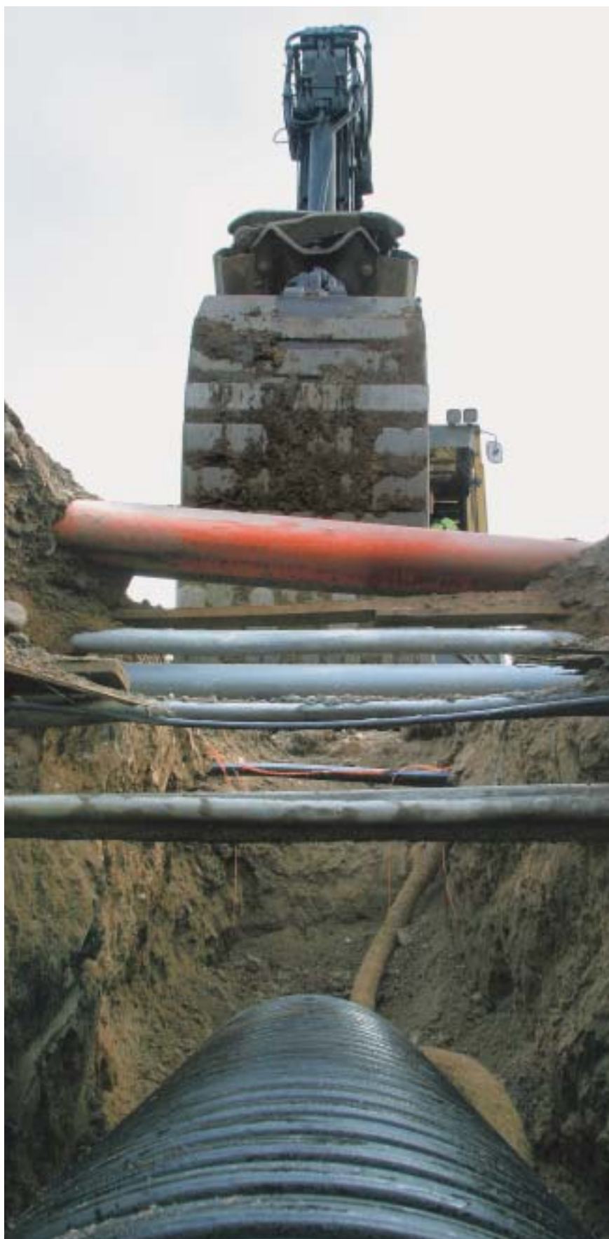
Det är viktigt att ta del av information om kabelanvisning innan man börjar gräva, allt för att undvika onödiga kabelbrott och störningar.
