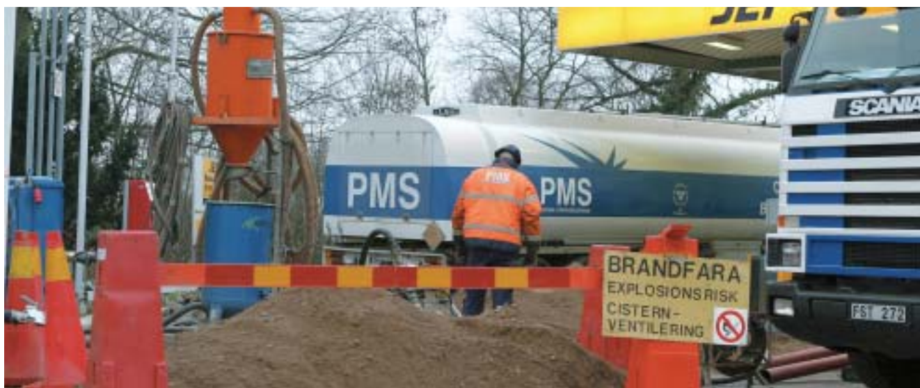
Arbetsområdet måste vara väl markerat med avskärmning eller annan säkerhetsmarkering för att undvika olyckor.
