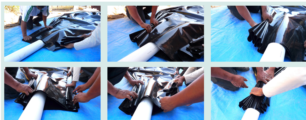
Figura 15: Secuencia fotográfica de cómo realizar los pliegues del plástico en forma de acordeón sobre la tubería.
