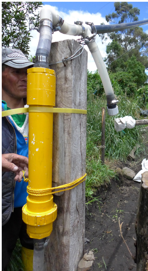
Figura 22: Arriba esquema y abajo foto de filtro de ácido sulfhídrico con purga de agua posterior
