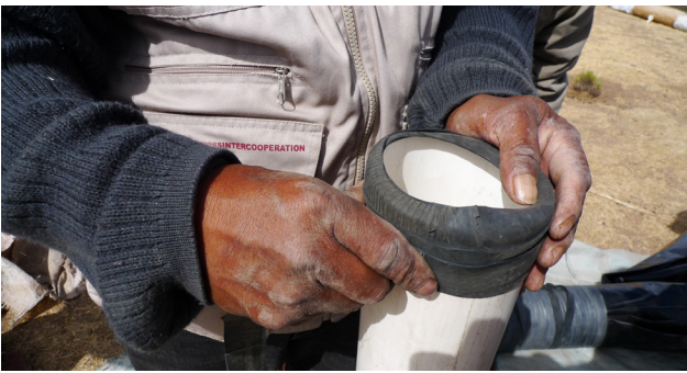
Figura 13: Ejemplos de protección de las tuberías: Arriba usando cinta adhesiva , y abajo usando liga de neumático.
