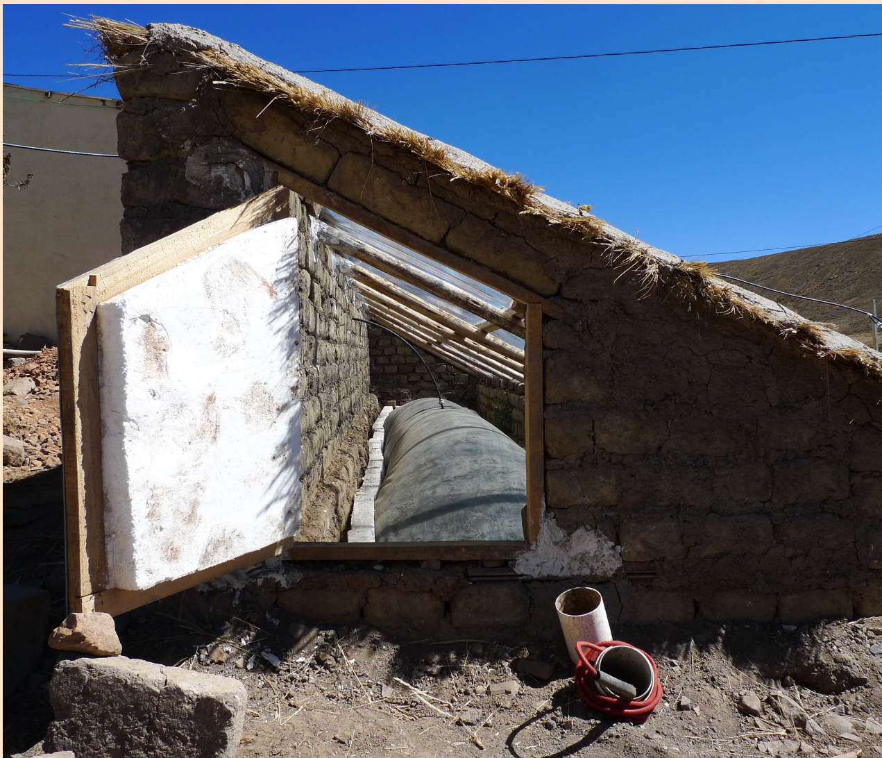
Figura 2: Biodigestor tubular adaptado a clima frío que considera aislante en zanja, color oscuro de plástico e invernadero compacto.
