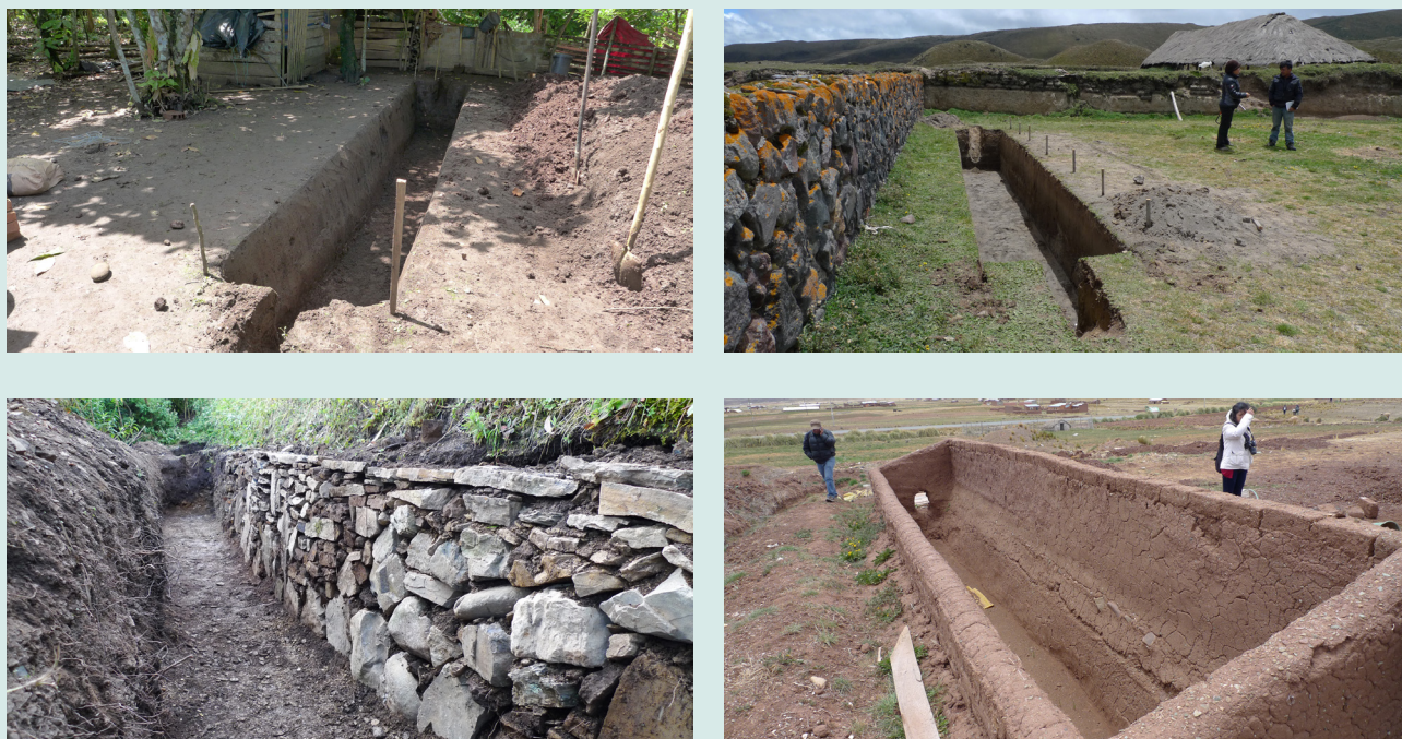
Figura 10: Ejemplos de zanjas para biodigestores tubulares.
