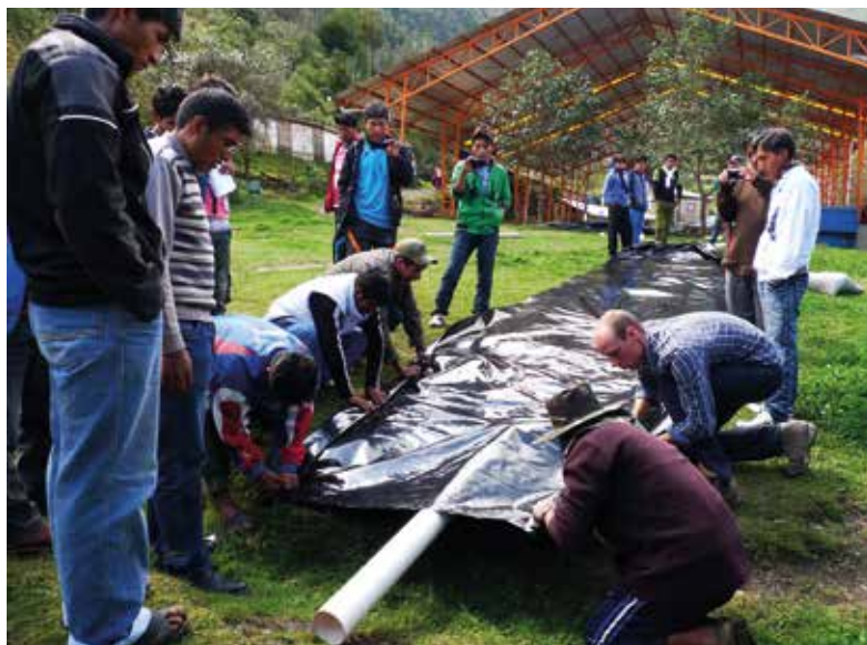
Ilustración 11. Armado de un biodigestor tubular como sistema de tratamiento de aguas residuales del Centro de Educación para Adultos de Titicachi (La Paz, Bolivia)
