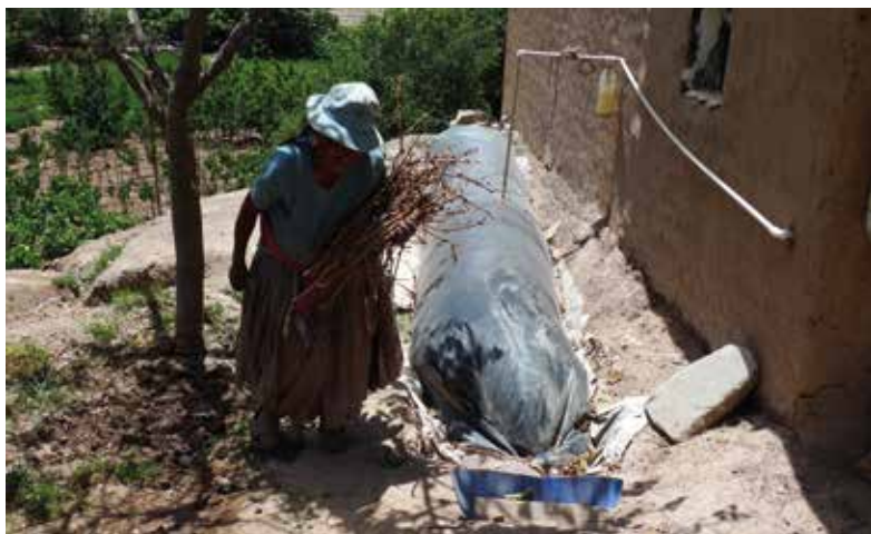
Ilustración 3. Biodigestor tubular instalado en el valle de Luribay (La Paz, Bolivia) en casa de Miguel Siles en 2010, cuya mayor motivación es el uso de biol en sus cultivos y la venta al por menor del fertilizante.
