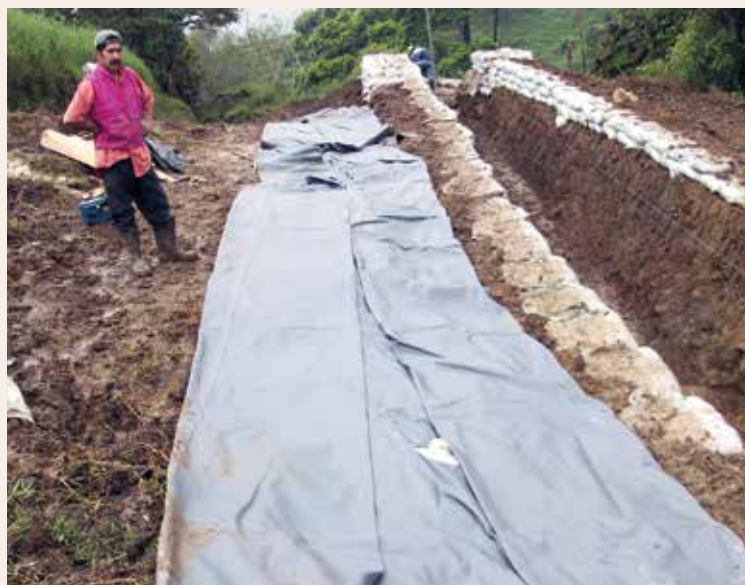
Carlos Núñez durante el proceso de instalación de su biodigestor de geomembrana de PVC en 2010.
