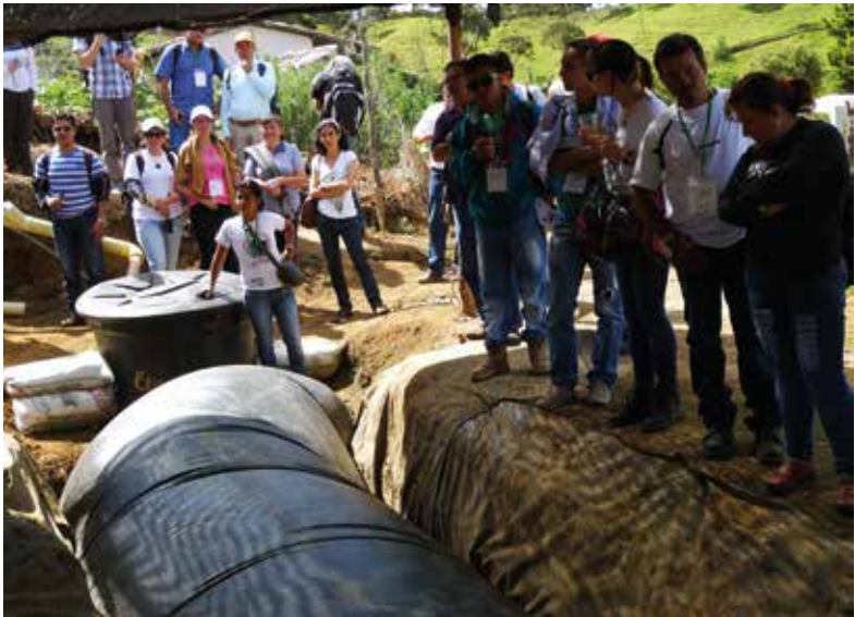
Ilustración 18. Biodigestor en geomembra para tratamiento de excretas de cerdo - Centro de Promoción de Energías Alternativas y Biomasa (TerraZoNet - Granja Porcicola Guarne - Municipio de Guarne -Antioquia-Colombia).
