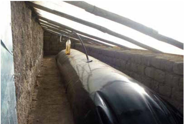
Ilustración 9. Un biodigestor familiar típico que se carga con 20 kg de estiércol (equivalente a un balde de pintura) y 60 litros de agua. En la foto, don Wilder carga un biodigestor familiar de altiplano en Viacha (La Paz, Bolivia) en 2011. Proyecto realizado en alianza del Endev-Bolivia de la GIZ y CIPCA.
