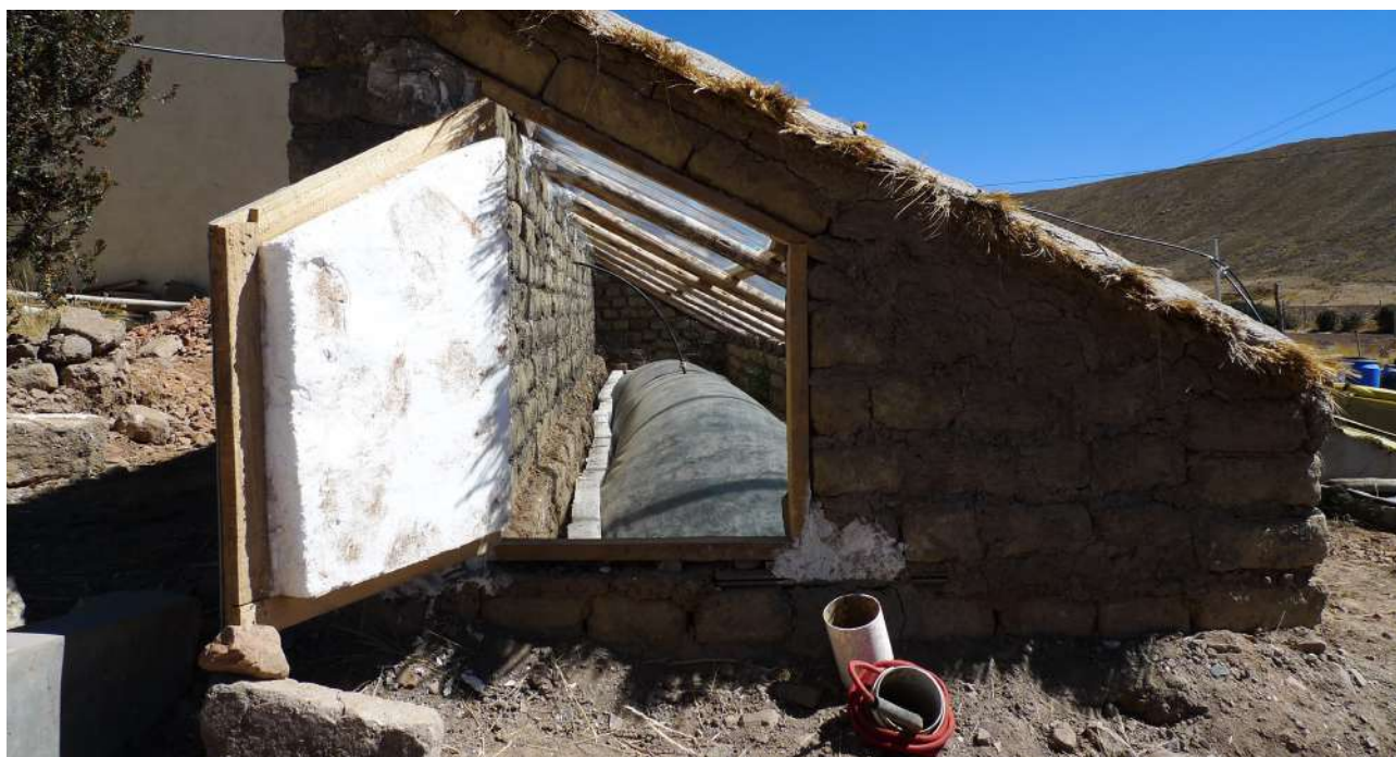
FIGURA 1 | Biodigestor tubular adaptado a clima frío que considera aislante en zanja, color oscuro de plástico e invernadero compacto.
