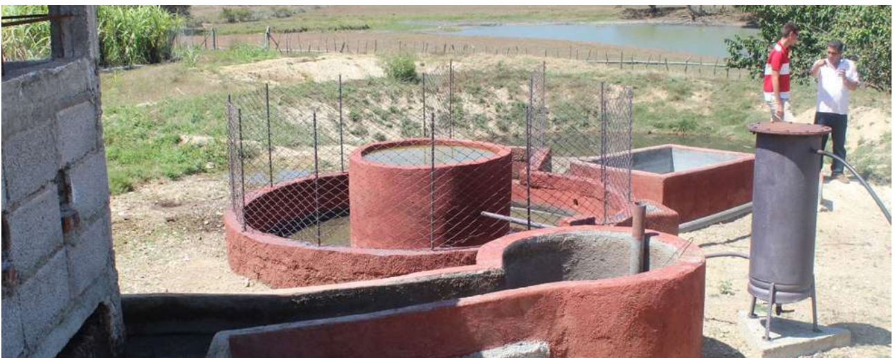
FIGURA 4 | Biodigestor de cúpula fija.
