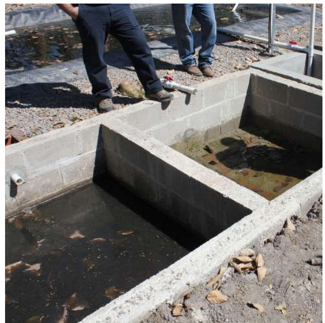
FIGURA 2 / SEGUNDA PARTE | Detalle del proceso de construcción del biodigestor.
