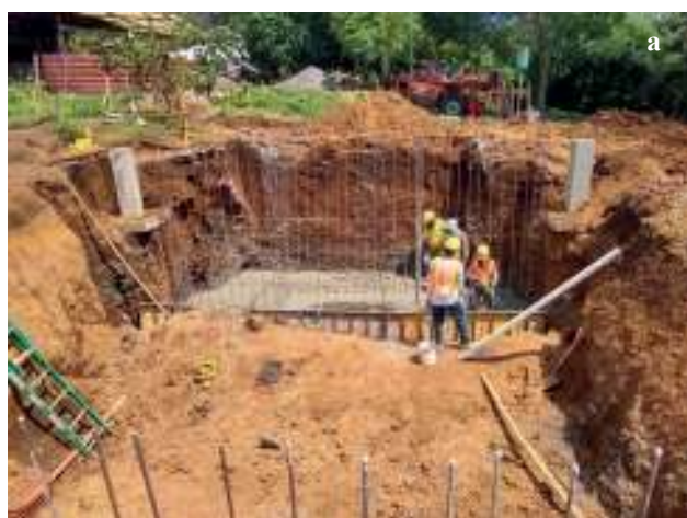
Figura 2 | Fotografías correspondientes a la infraestructura de: a) hueco del biodigestor (durante su construcción), y b) el techo para el biodigestor. Fuente: elaboración propia.
