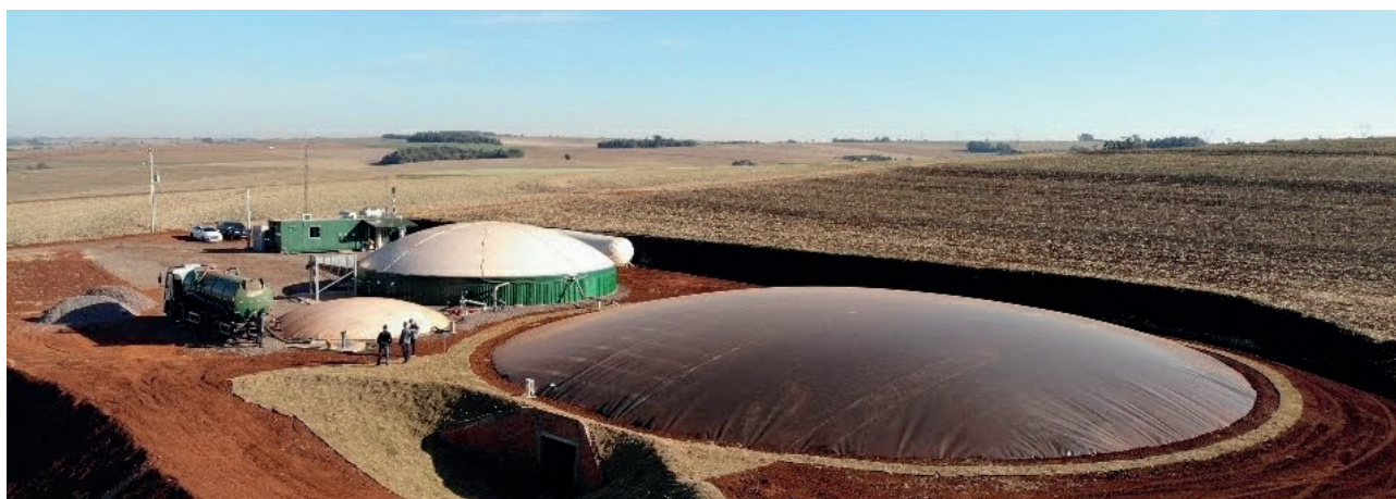
Figura 1 | Usina Biokohler, composta de biodigestor CSTR e um BLC.
