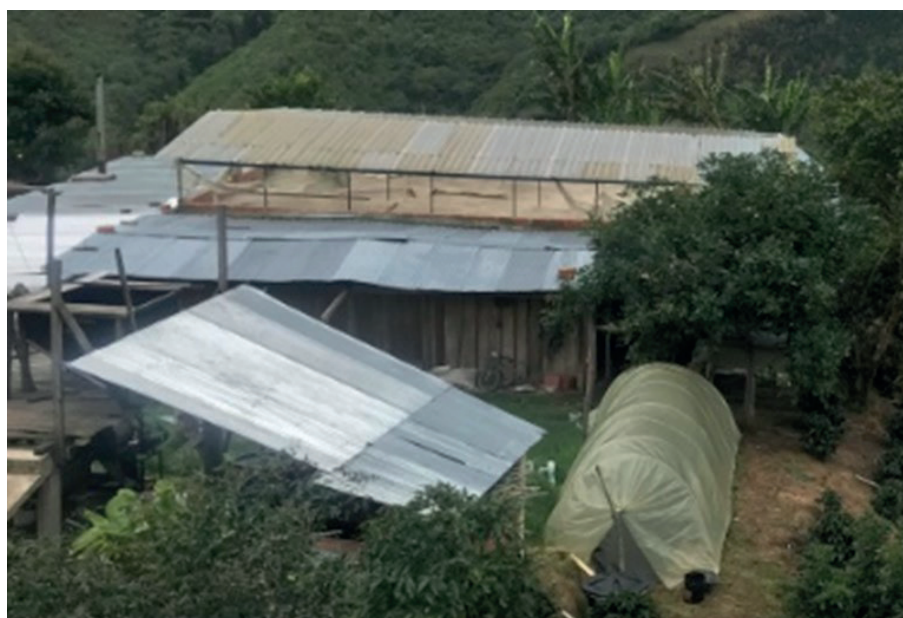
Figura 3 | Cubierta de biodigestores.
