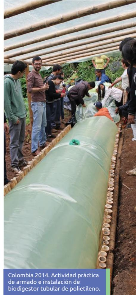
Colombia 2014. Actividad práctica de armado e instalación de biodigestor tubular de polietileno.
