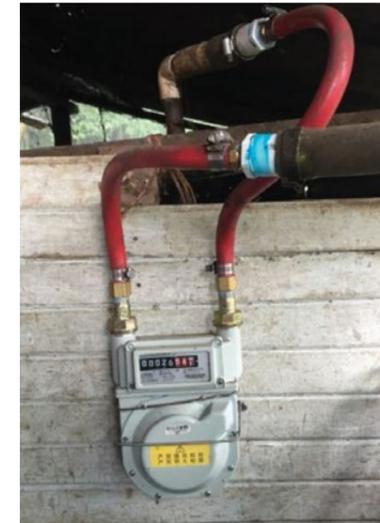
Figura 1. Flujómetro instalado para la medición de biogás.
