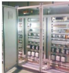
Armario eléctrico con enclavamientos de seguridad para el control total de la mezcladora.
